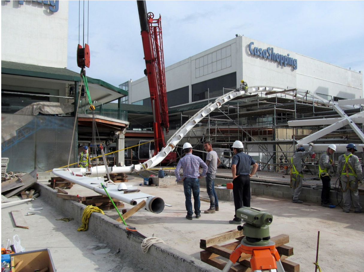
פרוייקט "Carioca Wave" ריו דה ז'נירו, ברזיל. 110 טון של ברזל בעל עקמומיות כפולה
